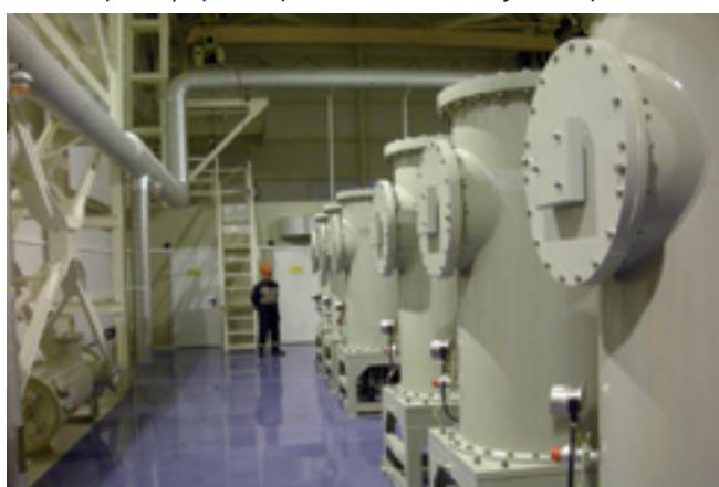
Индии от компании «Виджай Электрикалс Лимитед». Трансформатор 220/110/10кВ, мощность каждой фазы 40МВА. Резервная фаза установлена на случай повреждения одной из трёх других, чтобы в течение суток можно было оперативно переподключиться и ввести оборудование в работу. «Поселковая» рассчитана «на рост», и в будущем здесь будет установлен еще один трансформатор мощностью не менее 120МВА.
