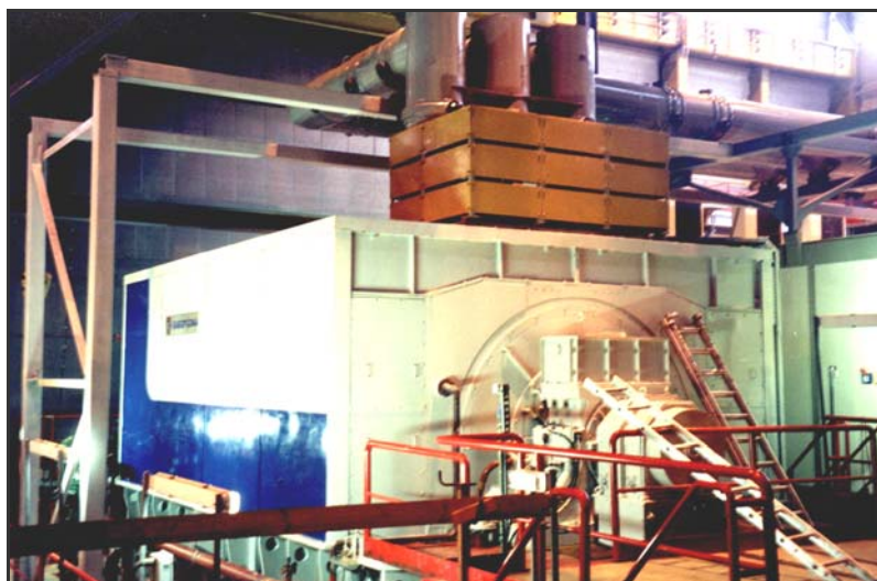
Рис.1. Турбогенератор мощностью 160 МВт для газовой турбины.
