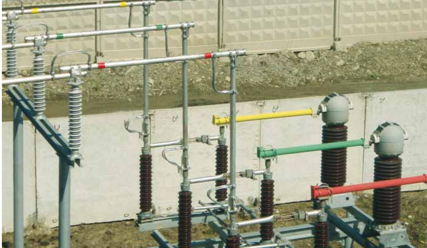
Варианты маркировки: цельная окраска и маркировочные кольца
