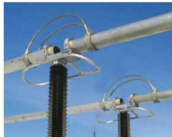
Жесткая ошиновка 500 кВ производства ЗАО ПФ «КТП-Урал» на испытаниях в НИЦ ВВА
