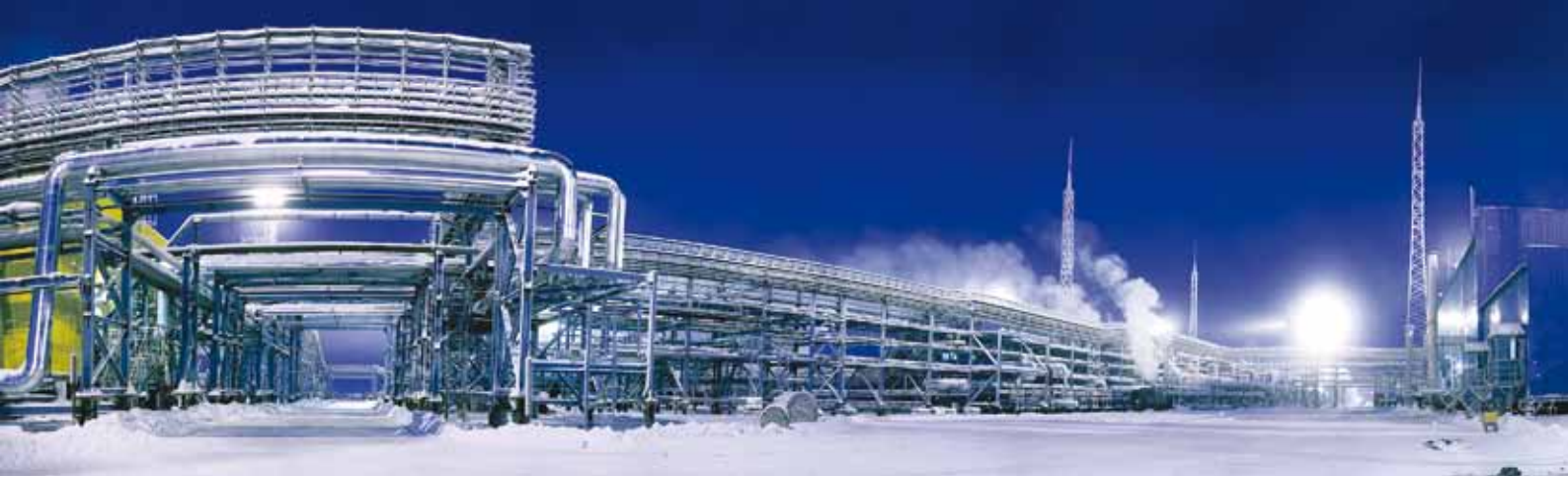
Эстакада технологических трубопроводов установки комплексной подготовки газа №2В Заполярного месторождения
